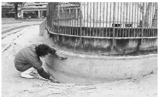
図2 小動物園造成土の被害
