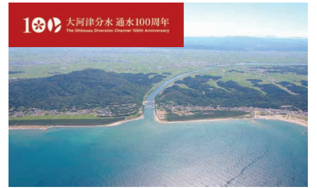
大河津分水河口域 (写真提供: 信濃川河川事務所)
